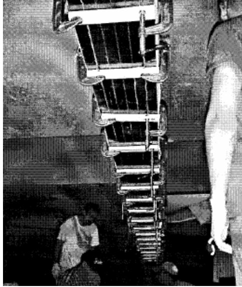
Figura 9-4 – Pultrusi di carbonio applicati usando morsetti removibili sul ponte I-704 in USA (Miller et al. 2001).
