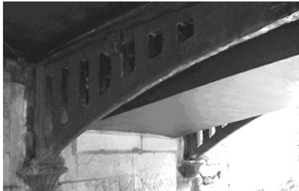
Figura 9-3 – Arco del ponte Corona dopo l'intervento con FRP.
