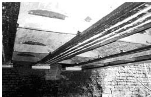
Figura 9-1 – Ponte Hythe in Inghilterra.
