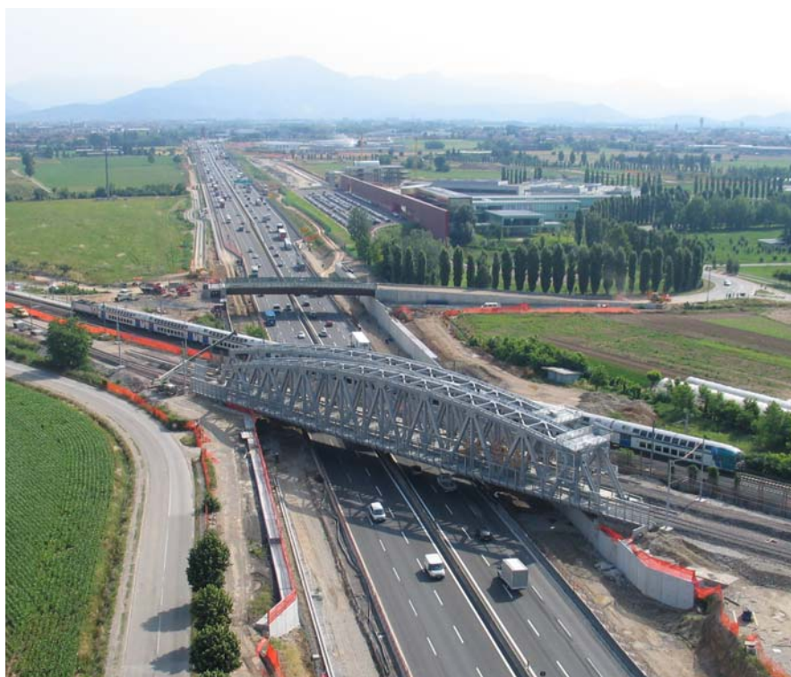
Figura 4.11.1 – Veduta dei due ponti ferroviari.
