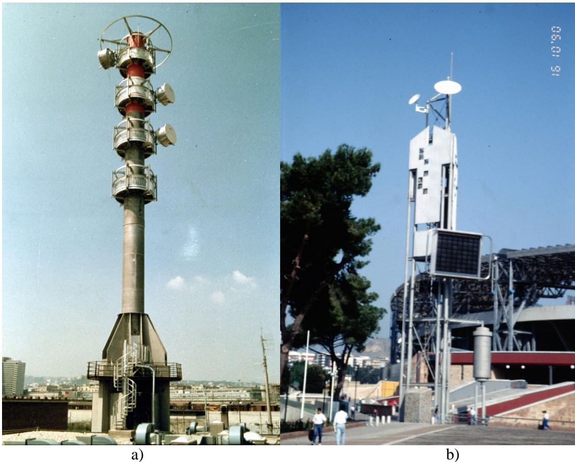
Figura 0-7.2: a) la torre porta-antenne paraboliche dell'ENEL a Napoli; b) la torre dell'Informazione di fronte allo Stadio San Paolo di Napoli.
