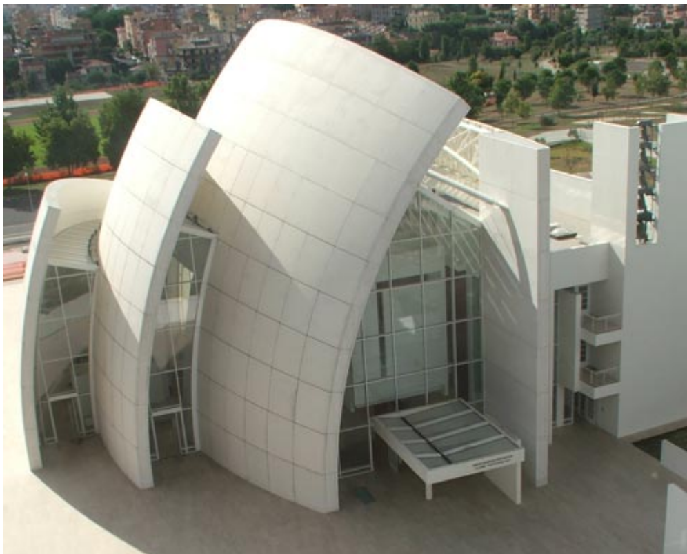
Figura 1-7 –Chiesa “Dives in Misericordia”, Roma, Italia, (1996/2003). Calcestruzzo bianco con biossido di titanio; resistenza a compressione: 40 MPa
