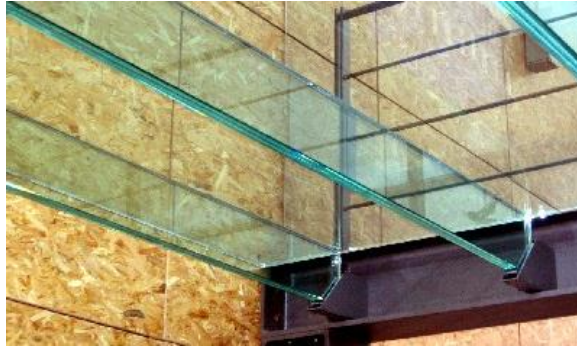
Figura 8.50. Particolare di estremità di travi inserite in apposite scarpe metalliche.
