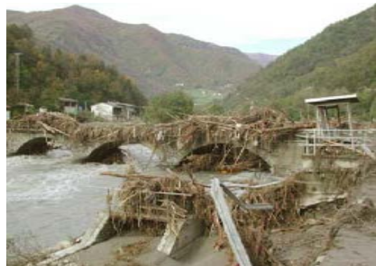
Figura 7.2: Interferenza con il corso d'acqua
